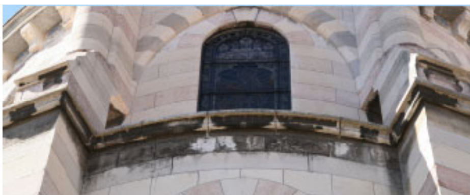
Joints évidés et sous-face lessivée de la corniche de l'abside du chœur.
