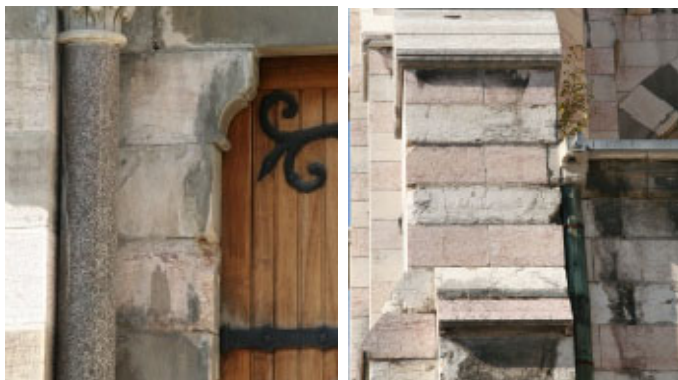
Eclatement de la pierre dû à la corrosion d'un fer (piédroit du portail sud). Eclatement de calcaire de type « Hauteville » (contrefort nord en façade sud).
