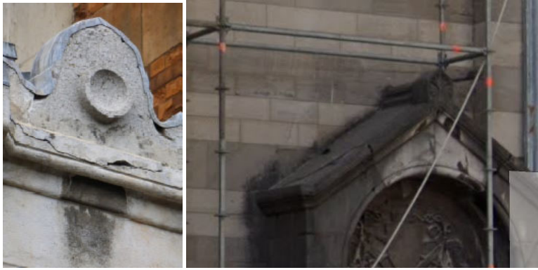
Fissuration de la corniche en calcaire noduleux blanc (bas-côté sud). Fronton du portail nord de la sacristie en élévation est.
