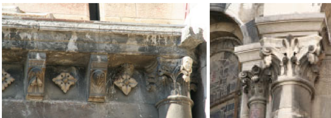
Croûtes noires sous la corniche de la chapelle nord occidentale. A noter, la dégradation de la pierre aux endroits où les croûtes se sont détachées, la présence de nids d'hirondelle et de dépôts de fiente, l'absence de protection de la gargouille et la blancheur des parties lessivées.
